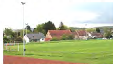
Le drainage du terrain de football qui date de 2008 ne donne plus satisfaction, il sera partiellement réhabilité. Photo V. Muller
