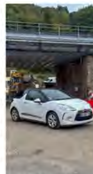
Après neuf semaines de travaux, la circulation est à nouveau possible. Photo R.L.
